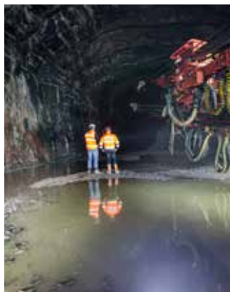
在埃斯波地下深处，一台山特维克DT1131i钻机挖掘出庞大的隧道网络。
