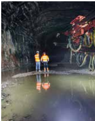
Głęboko pod miastem Espoo wiertnica Sandvik DT1131i drąży rozległą sieć tuneli
